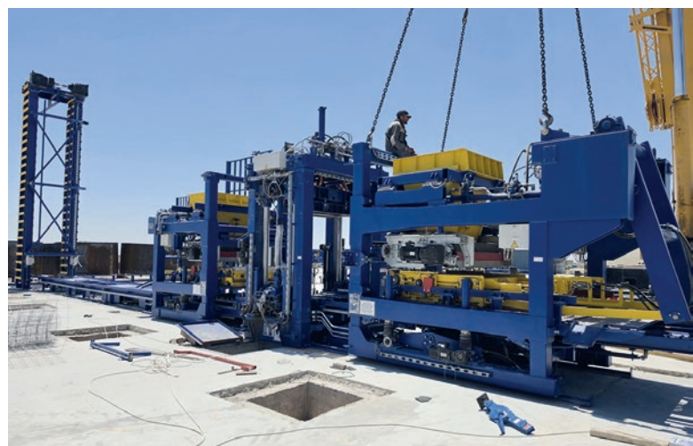
Ankunft der XL-R 9.1 in Algerien: Das Herzstück der Anlage wird montiert.
