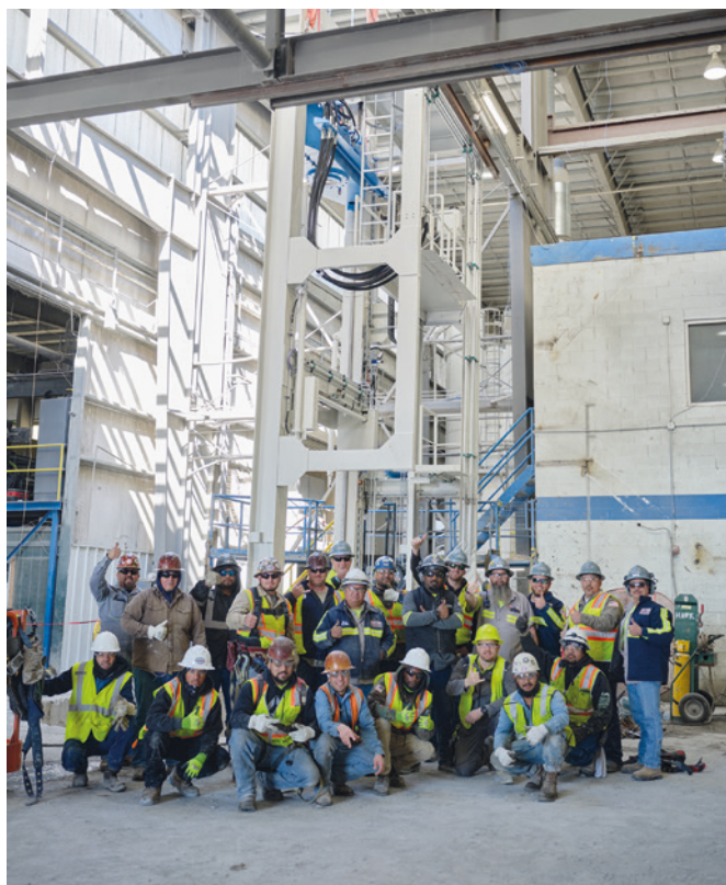
Remplacement réussi de la presse radiale
