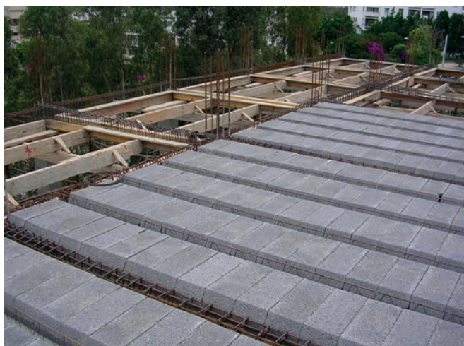
Einbausituation Deckenstein auf Baustelle
