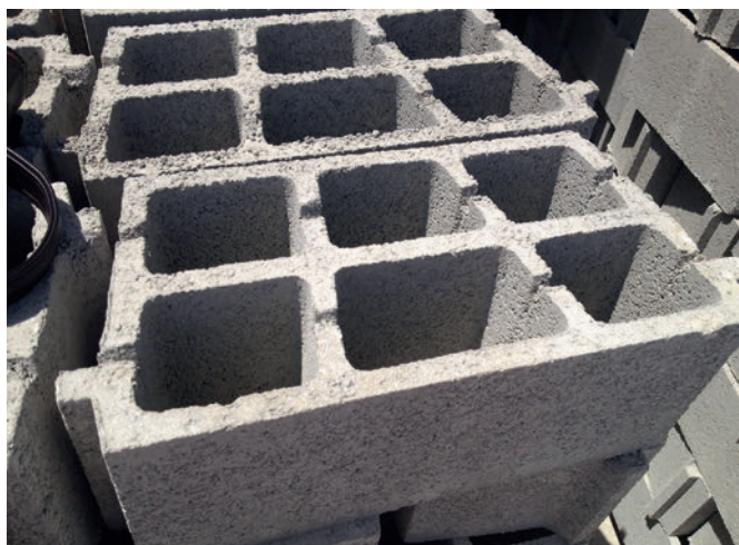
Deckenstein in üblicher Ausführung
