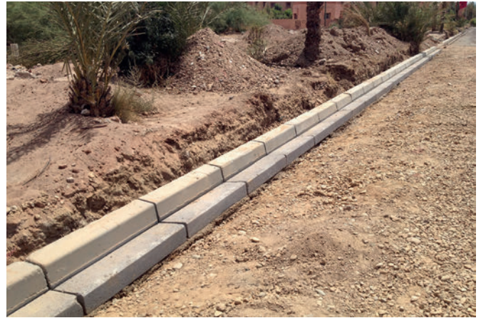
Baustelle in der Nähe von Marrakech
