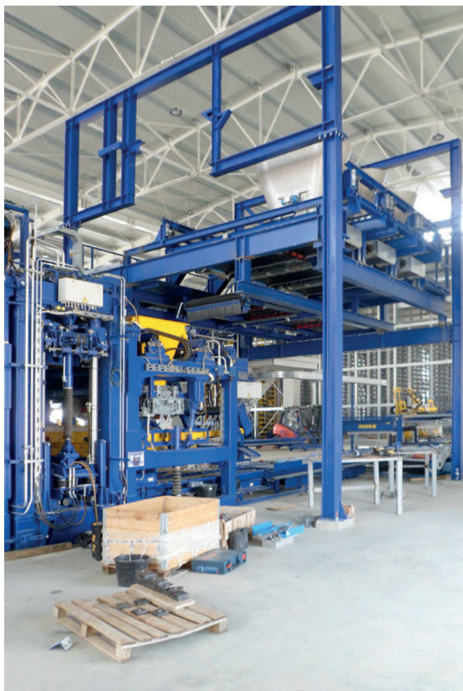
Die Montage des eigentlichen Herzstücks der Produktionsanlage, der Masa XL-R mit Multi-Color-System (hier für Vorsatzbeton) erforderte einige Routine und Feingefühl.
