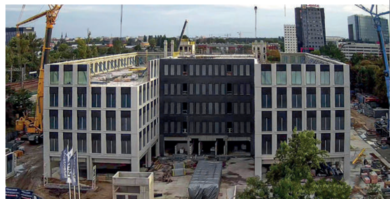
Büro- und Hotelkomplex B10 in Breslau (Polen)
