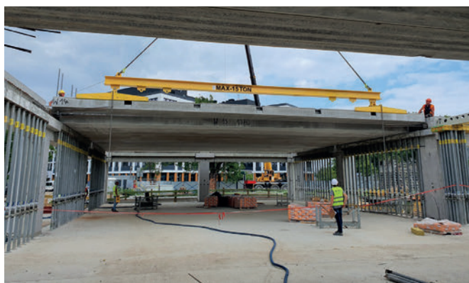
Die Fertigteile können schneller und sicherer an der Baustelle eingesetzt werden.
