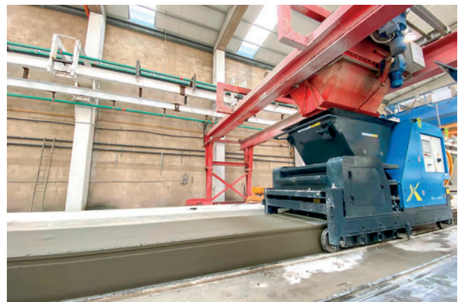
Mit den neuen Maschinen können sie qualitativ hochwertige Spannbetonfertigdecken herstellen und gleichzeitig ein hohes Maß an Feuerbeständigkeit garantieren.
