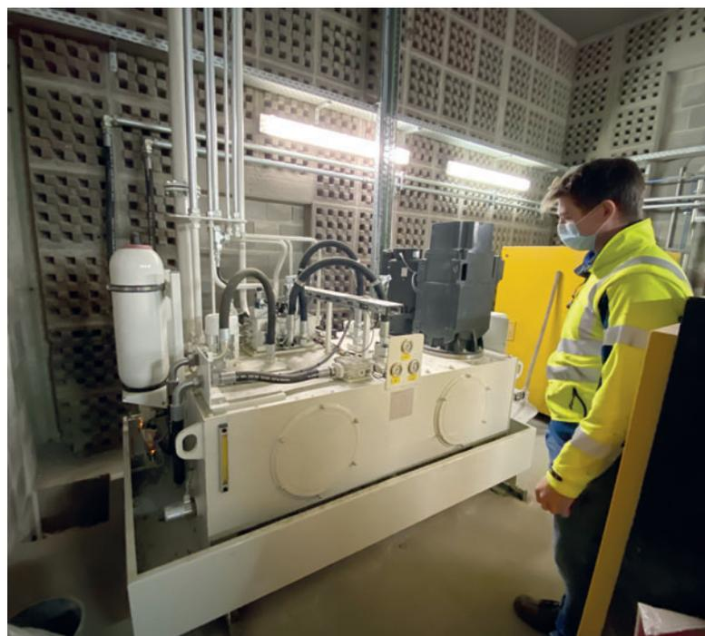
Fig. 5: Idrraulica della pressa
