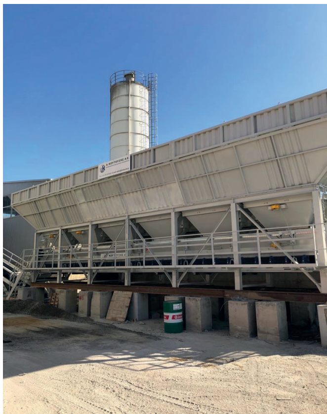
Impianto di dosaggio di Koutousis S.A.
