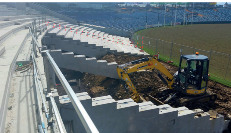
Die mit dem Gleitfertiger produzierten Betonfertigteile wurden bereits beim Bau zweier Stadien eingesetzt.
