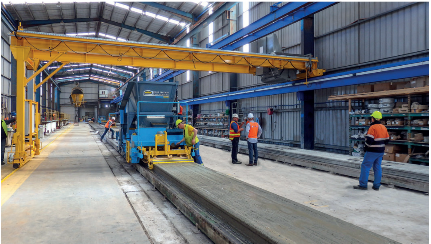
Mit dem Universalgleitfertiger stellt Westkon Precast Spannbetondecken mit Höhen von 20 cm bis 50 cm her.
