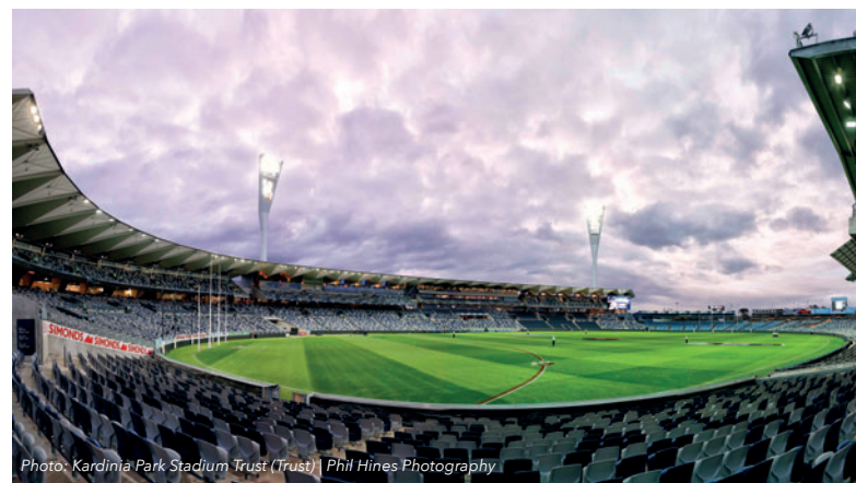
Für das Simonds Stadium in Geelong etwa produzierte Westkon Precast über 8.500 m 2 Spannbetondecken und 1.250 m 2 Sitzplatten.
