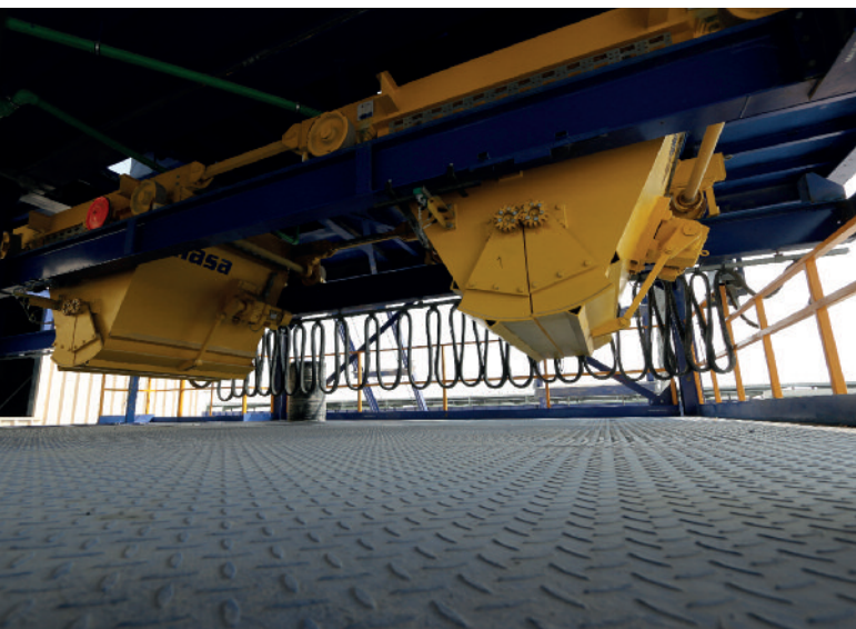
Mieszanka konstrukcyjna i mieszanka licowa są transportowane zasobnikami Masa poruszającymi się po estakadzie do zasobników wibroprasy.
