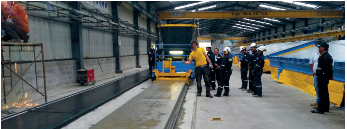
Die Spannbetondecken werden auf zwei 114 m langen Bahnen mithilfe eines Gleitfertigers von Echo Precast Engineering produziert.
