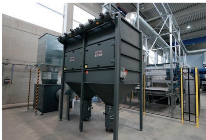
Централизованная система пылеудаления Rotho
