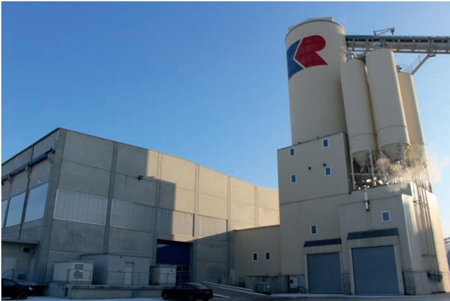
Башенная БСУ Liebherr снабжает бетонной смесью производство плит перекрытия и новую бетоноформовочную линию
