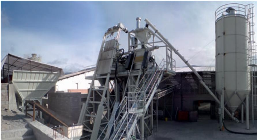
Instalación de mezcla Euromecc con silo de cemento, depósitos, elevador de cangilones y mezcladoras
