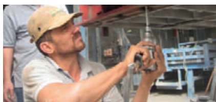
Trabajos de montaje durante el cambio de piezas de desgaste
