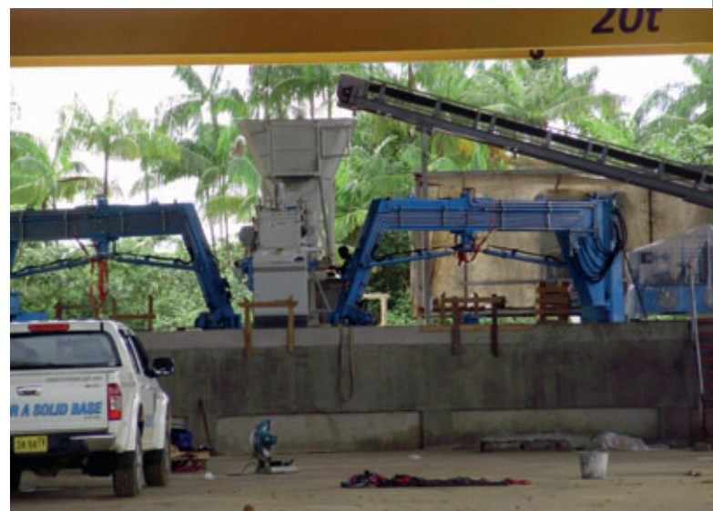
Installation de la nouvelle installation de production
