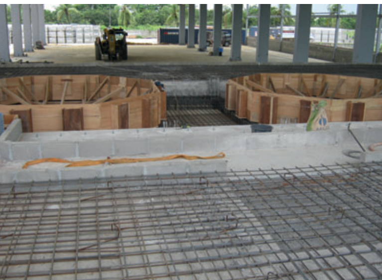
Préparation des fondations
