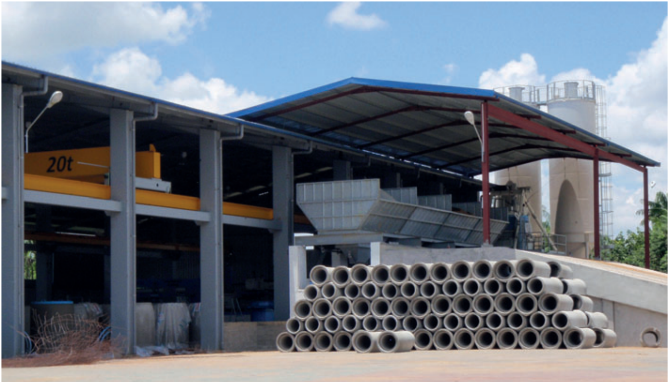
Vue extérieure de la nouvelle installation de production de tuyaux
