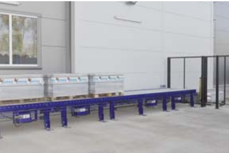
Transport paczek na stanowisko odbioru wózkiem widłowym.
