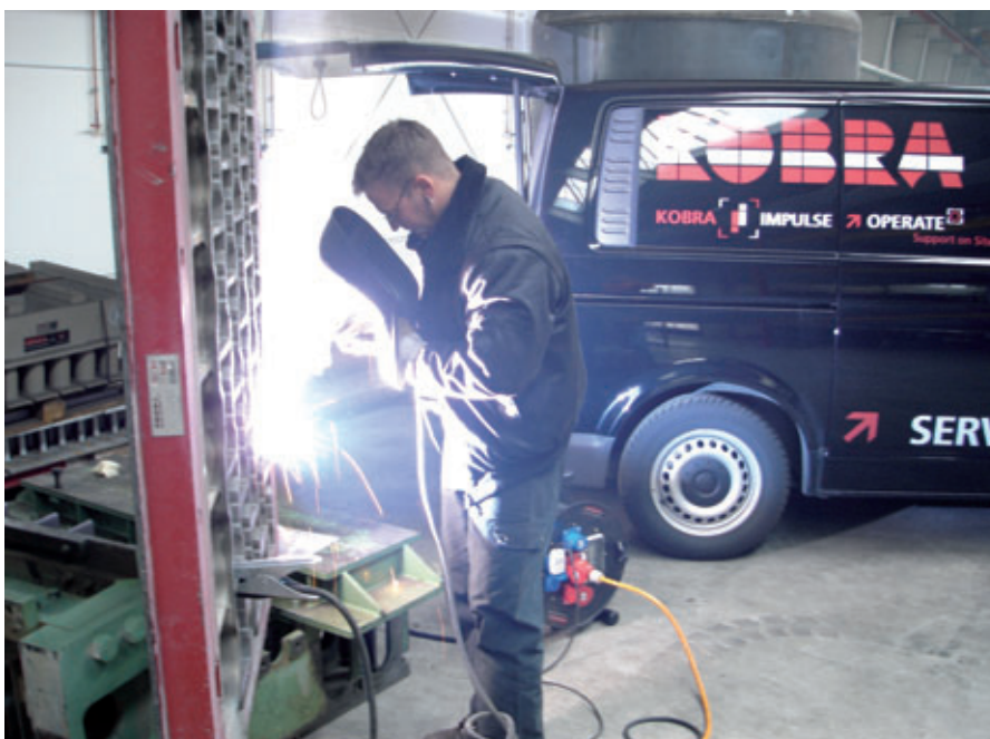
Un collaboratore dell'assistenza esegue una riparazione in uno stabilimento di produzione del calcestruzzo
