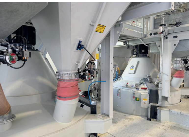
Основными элементами новой установленной двойной БСУ являются два планетарных смесителя Wiggert типа HPGM 1875
