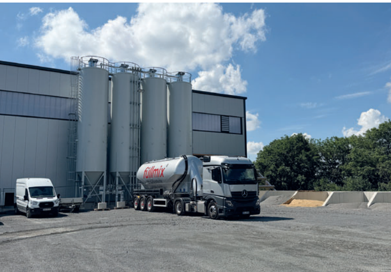
Новый производственный цех с силосами для заполнителей и вяжущих материалов
