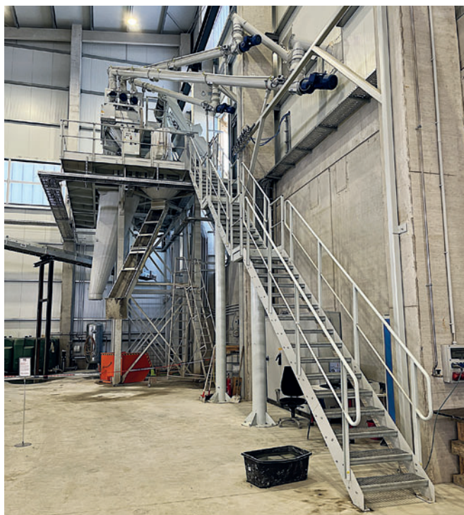
Двойная БСУ Wiggert была поставлена в заводских предварительно собранных модулях, что позволило провести быстрый и простой монтаж
