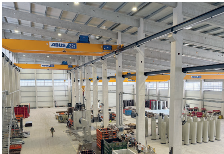
Помещение производственного цеха площадью около 5000 м 2
