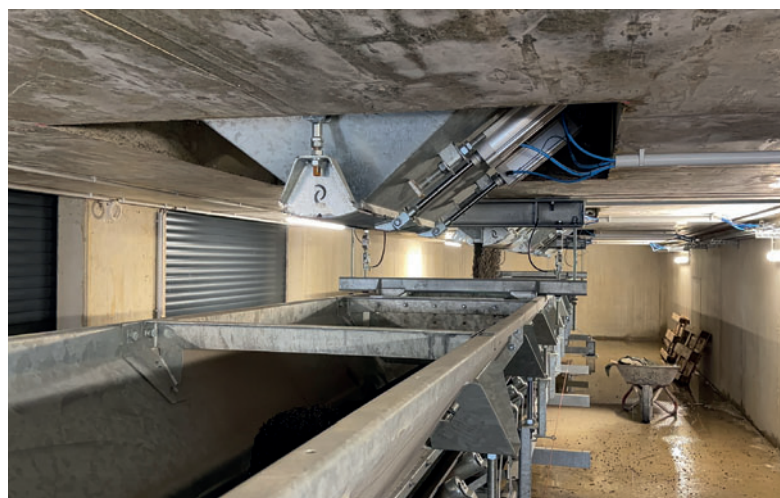
Дозирование заполнителей происходит через встроенные в дно силосных камер двойные дозирующие затворы
