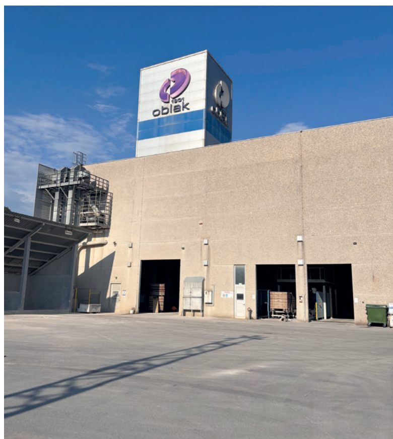
Компания Oblak Group d.o.o. производит бетонные изделия на предприятии в Логатеце на существующее производственной линии, которая на протяжении многих лет постепенно расширялась
