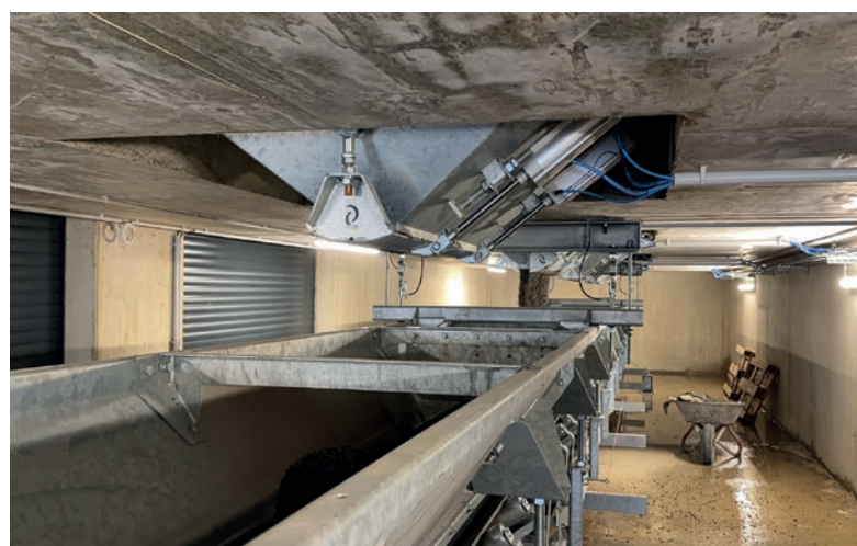
Kruszywo jest dozowane przez podwójne zasuwy dozujące zabudowane w dnie komór zasobnika.
