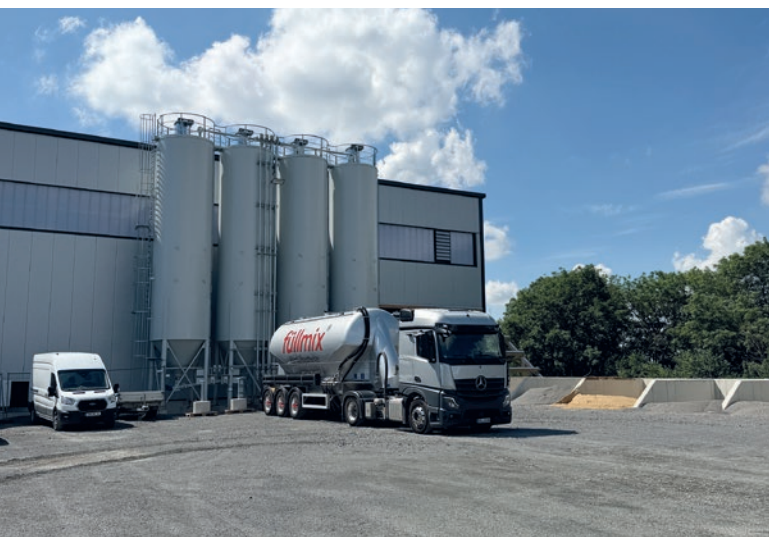
Widok na nową halę produkcyjną z zasobnikami kruszywa i silosami na spoiwo.
