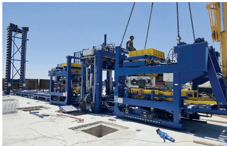
Przybycie wibroprasy XL-R 9.1 do Algierii: trwa montaż serca linii produkcyjnej.
