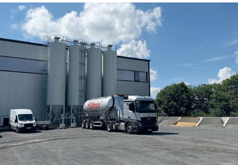
Vista sul nuovo capannone di produzione con i silo per aggregati e i silo per leganti.
