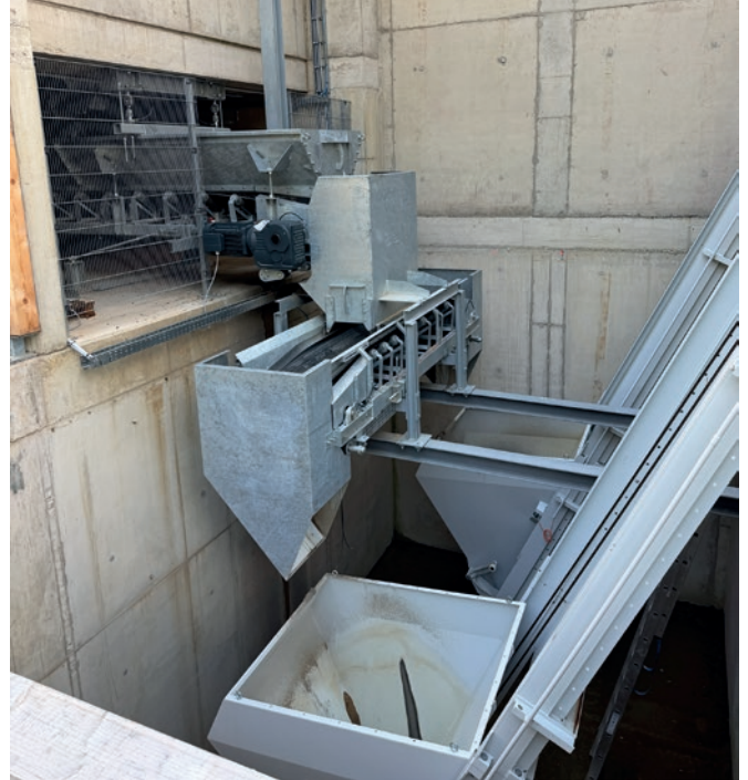
Il nastro di distribuzione riempie, a seconda del senso di marcia, uno dei due montacarichi di caricamento.
