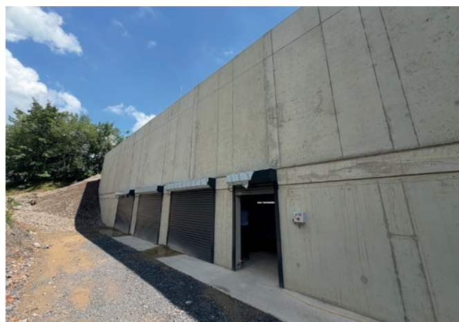
Lo stoccaggio degli aggregati avviene in un silo in serie a 7 camere disposto sotto il pavimento, con un volume complessivo di circa 400 m³.
