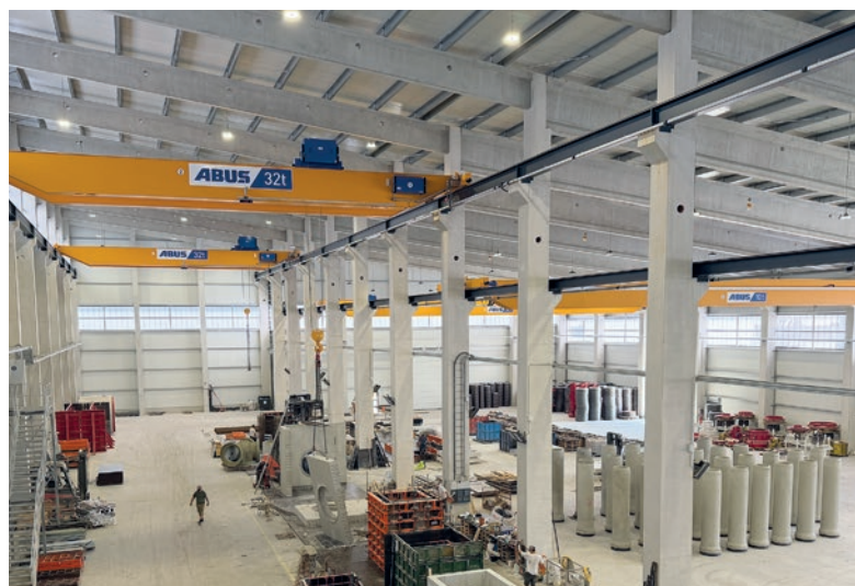
Vista all'interno del capannone di produzione di circa 5.000 m².
