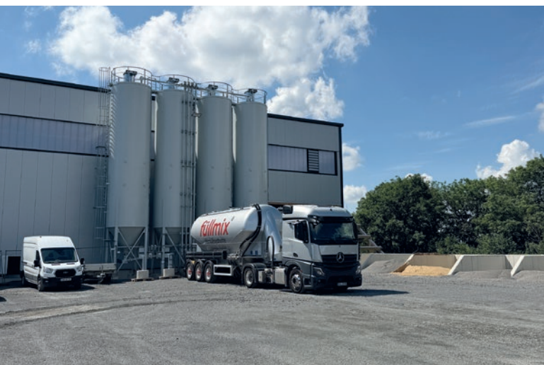
Vue sur le nouveau hall de production avec les silos à granulats et à liants.
