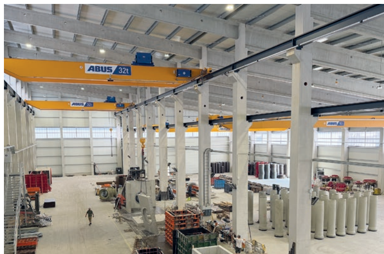
Vue sur le hall de production d'environ 5 000 m 2 .
