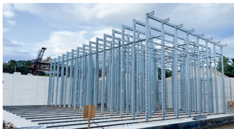
Après l'achèvement de la fondation, le montage de la construction métallique et du système de rails a commencé.
