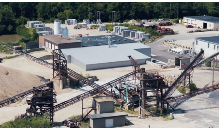
Genest Concrete Works installe le premier système breveté Kraft Curing Rack aux États-Unis.
