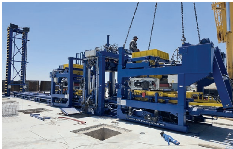
Llegada de la XL-R 9.1 a Argelia: Se monta el elemento central de la instalación.
