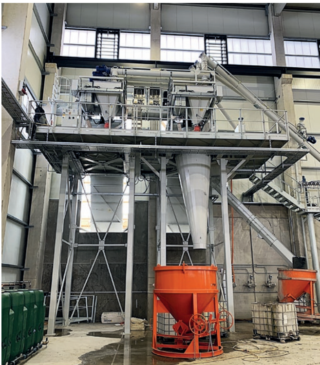
La instalación de doble mezclado de Wiggert se suministró en módulos prefabricados en fábrica, lo que permitió un montaje rápido y sencillo.
