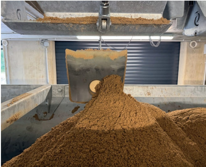
En las compuertas de las cámaras de arena del silo se colocan sondas de medición de humedad.
