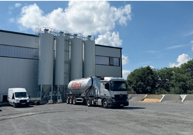
Blick auf die neue Produktionshalle mit den Gesteinskörnungs- und Bindemittelsilos
