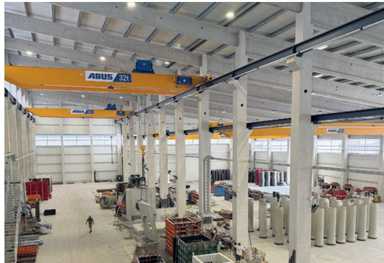
Blick in die ca. 5.000 m 2 große Produktionshalle
