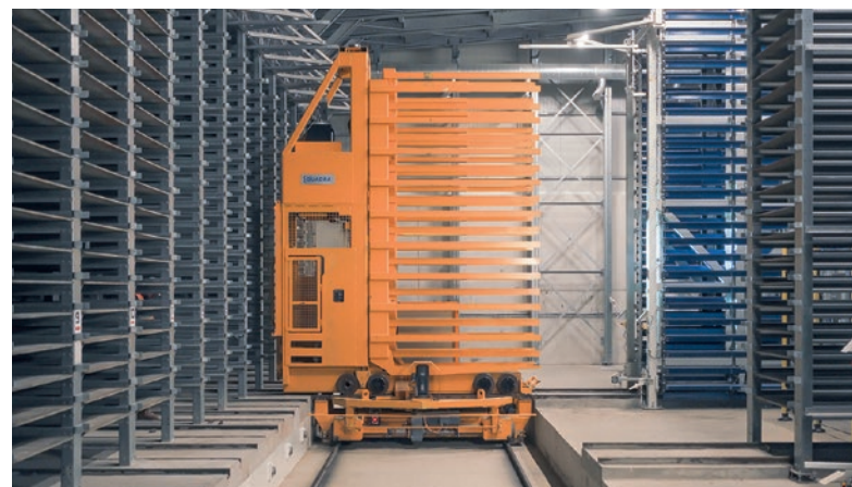
Im Gegensatz zu herkömmlichen Regalsystemen ist das Kraft-Rack-System selbst ein integraler Bestandteil des Härtungsprozesses.
