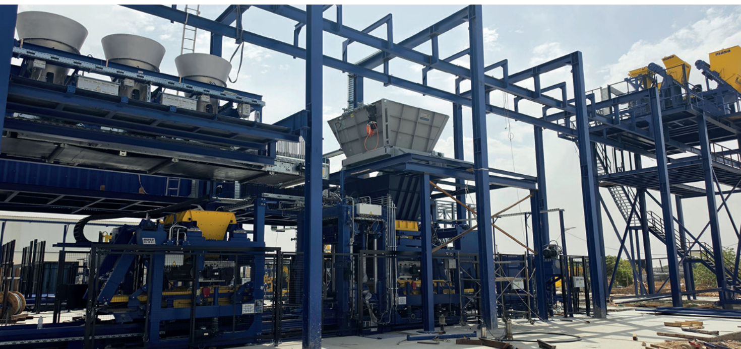
仍在建设中但已初具规模：配备已安装的多色彩系统的 Masa XL-R 9.1 构成了新生产线的核心
