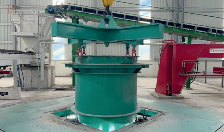
Podnoszenie elementu za pomocą suwnicy.
