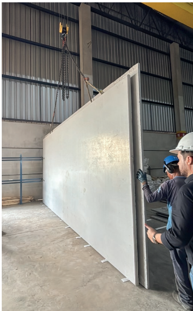
Dzięki nowej obrotnicy w zakładzie prefabrykatów pod São Paulo można teraz produkować również ściany podwójne o nienagannej powierzchni betonu architektonicznego.
