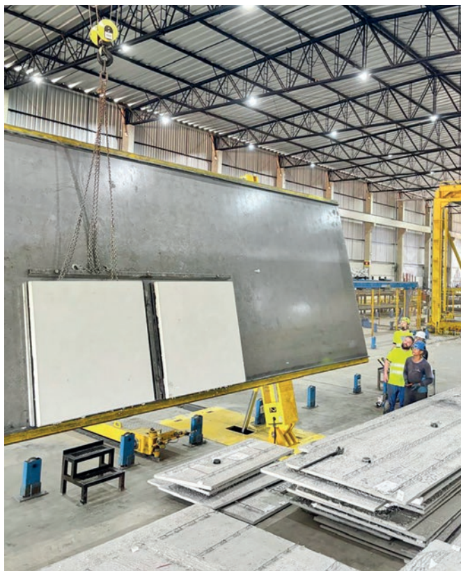
Po zakończeniu produkcji elementy ścian podwójnych są pionizowane za pomocą stołu uchylnego, zdejmowane suwnicą i transportowane dalej w pozycji montażowej.
