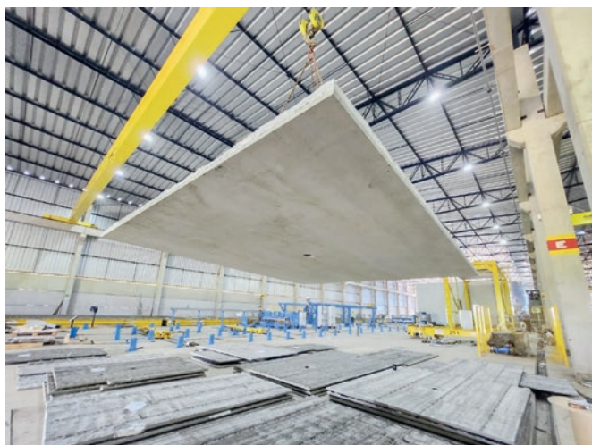
Prefabrykaty są produkowane i transportowane pod kontrolą oprogramowania, a częściowo w sposób w pełni automatyczny – co pozwala zaoszczędzić czas oraz pieniądze, a także zwiększa bezpieczeństwo produkcji.
