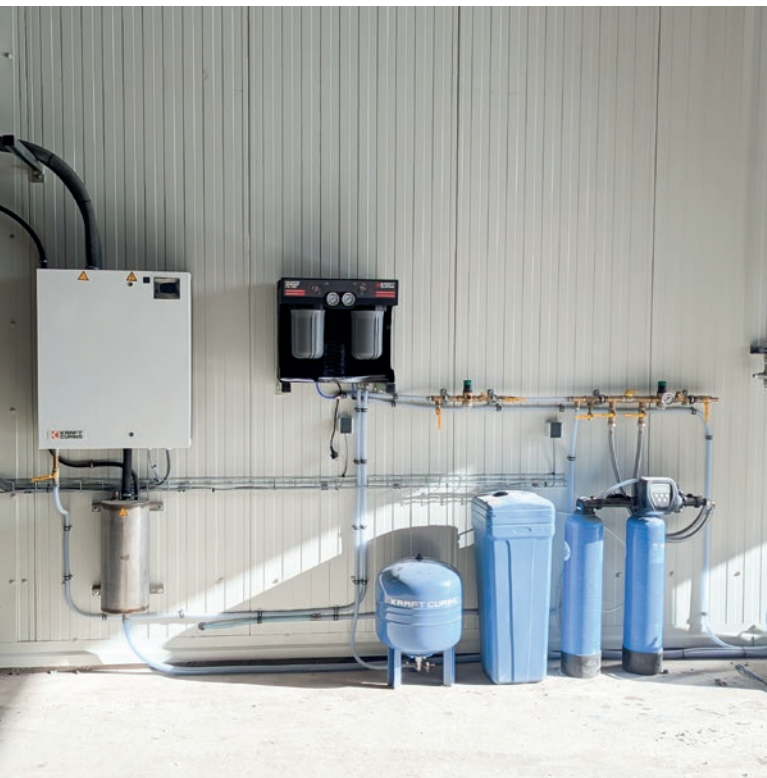
Para garantizar una regulación precisa de la humedad del aire, Kraft ha incorporado a la cámara de curado su sistema de humidificación AutoFog.
