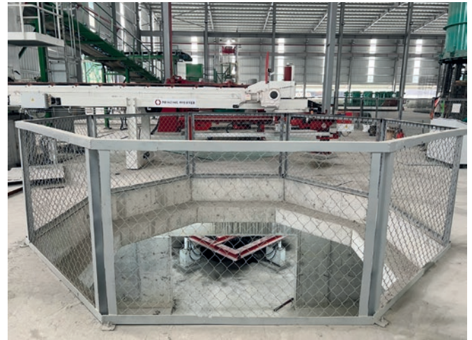
Vorbereitete Grube für eine künftige Erweiterung auf zwei Stationen
