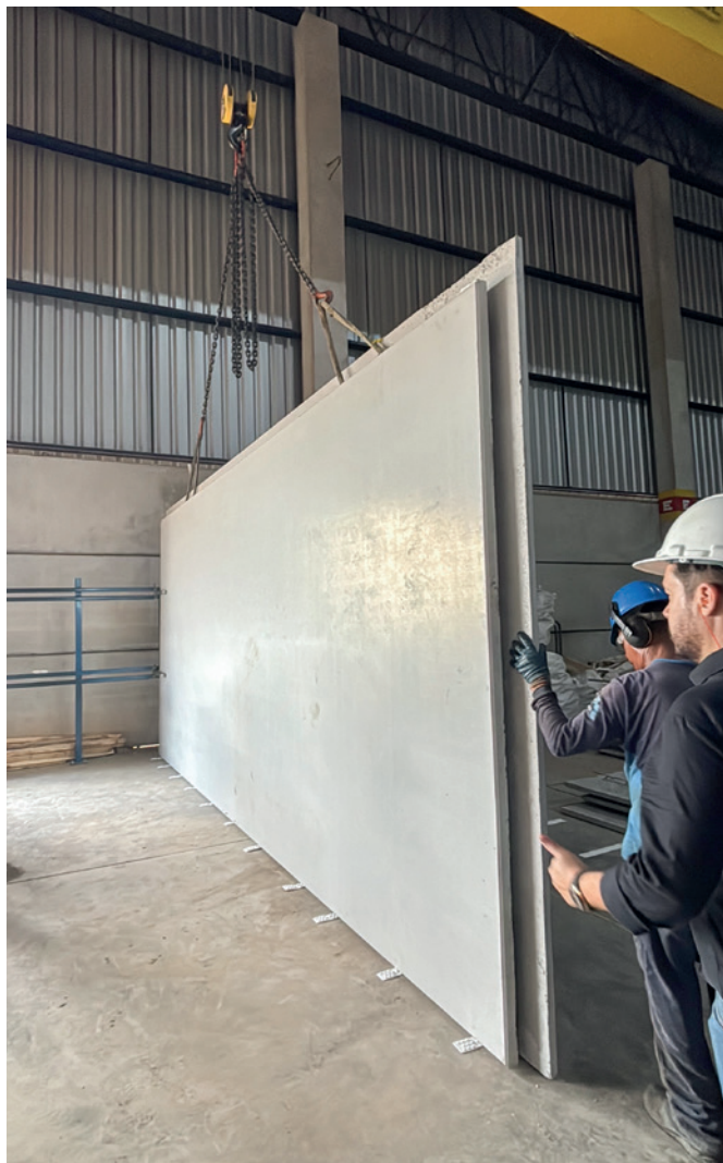
借助新的翻转装置，这家位于圣保罗附近的预制工厂现在还可以生产具有清水混凝土表面的双面叠合墙
