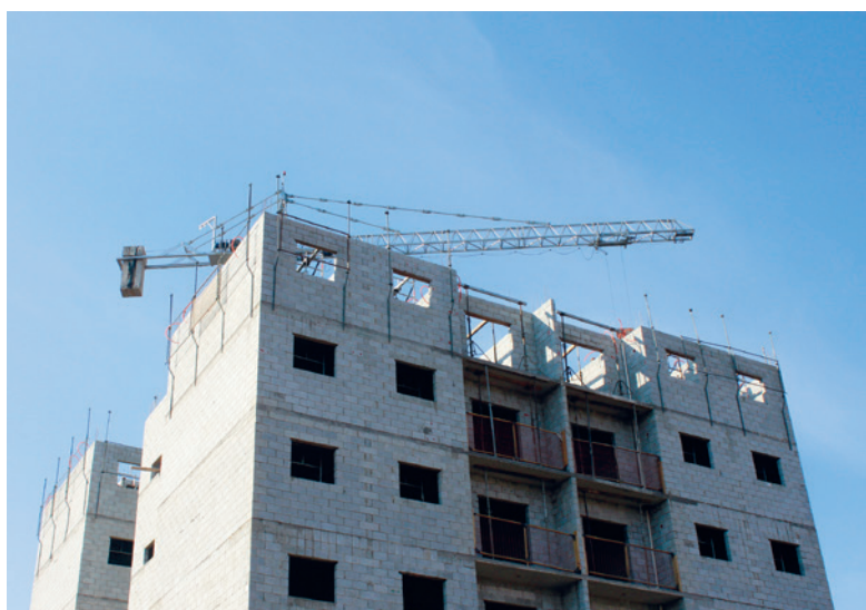
一栋已安装使用了这家巴西先驱企业所生产的带现浇叠合层预制楼板的建筑
