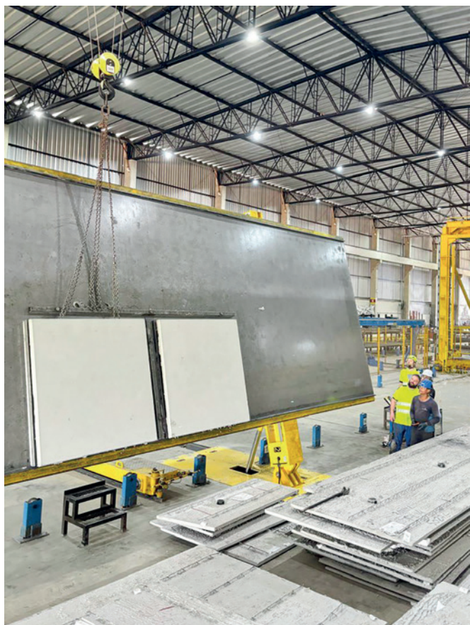
生产完成后，双面叠合墙构件通过翻转机构立起，由起重机吊运至预定安装位置
