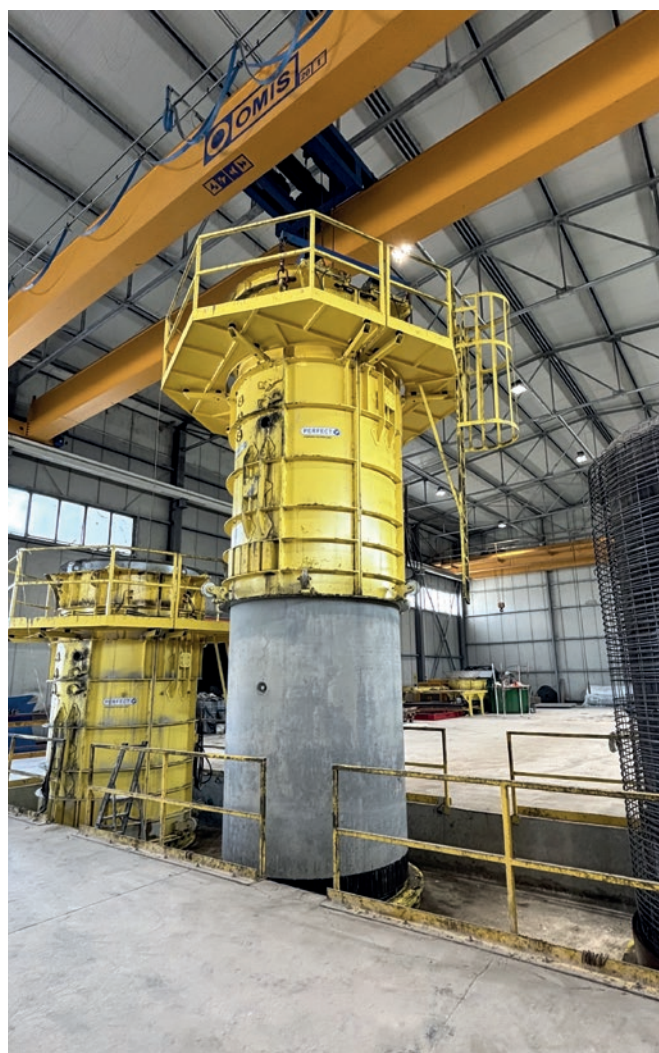
Rozformowanie formy zewnętrznej – kolejna gotowa rura.
