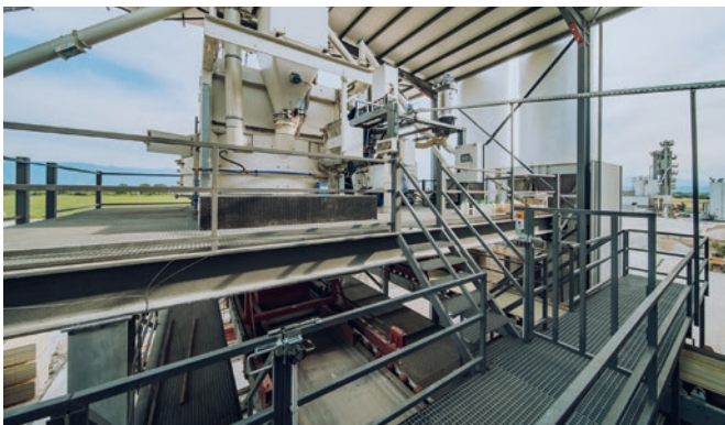
Miscelatore del calcestruzzo per lo strato interno SM 3375
