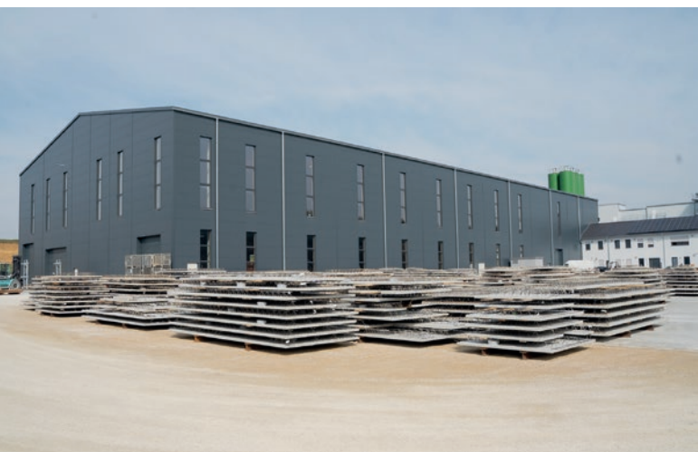
Sur le nouveau site de Wöhrl, le carrousel à palettes moderne produit des prédalles et des prémurs ; les murs thermiques et massifs suivront
