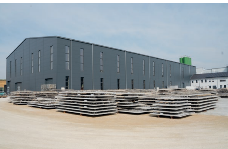
En la nueva sede de Wöhrl se fabrican prelosas armadas y muros dobles con una moderna instalación de circulación de bandejas; le seguirán muros térmicos y muros macizos.
