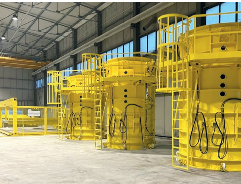
Anlage zur Liner-Bearbeitung und Rohr-Gießformen von Schlüsselbauer Technology vor finaler Inbetriebnahme
