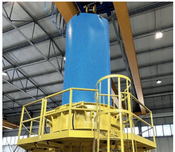
Einsetzen des aus Agru-Betonschutzplatten gefertigten Liner-Zylinders in die 4 m hohen Rohr-Gießformen
