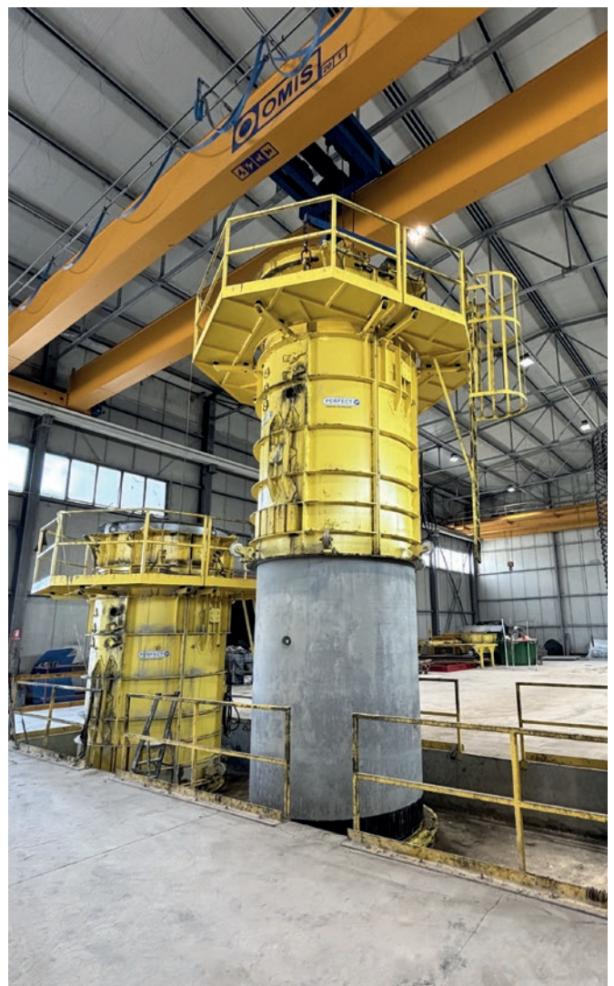
Entschalen der Außenform - ein weiteres Rohr steht bereit zum Auslagern
