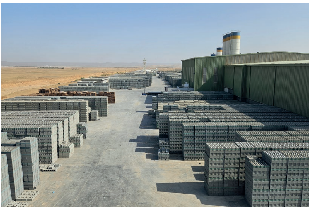
Vista general de la planta de Al Wady
