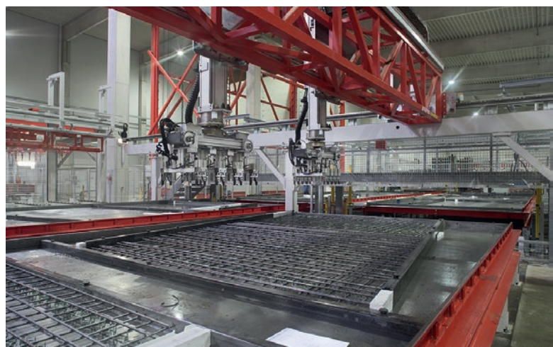
Kratownice i pręty zbrojeniowe są precyzyjnie rozmieszczane na podkładach za pomocą chwytaków.
