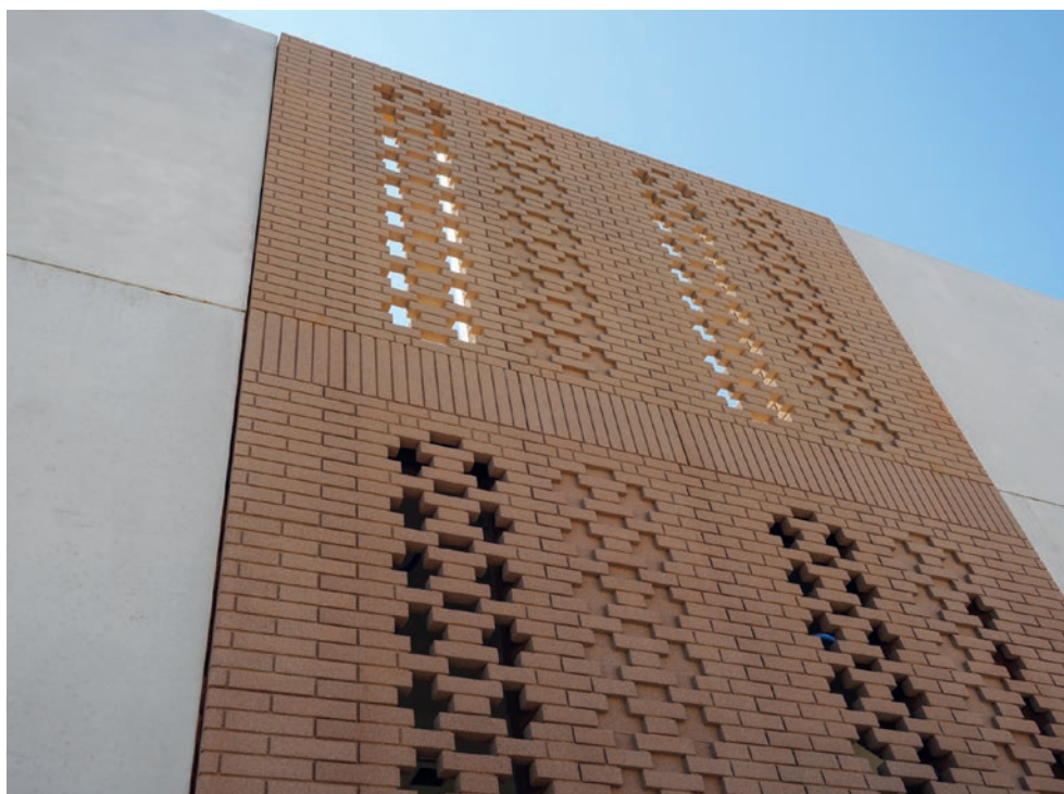
Element fasadowy z drukowaną w 3D imitacją cegły.
