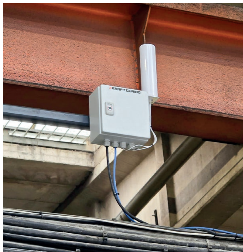
Bezprzewodowe wzmacniacze sygnału, rozmieszczone w całym zakładzie lub na terenie fabryki, zapewniają odpowiednią siłę sygnału na dużym obszarze. Przewód termopary do pomiaru temperatury wewnętrznej betonu.
