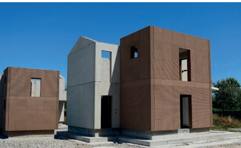
Casa vacanze allo stato grezzo con elementi di facciata stampato in 3D.
