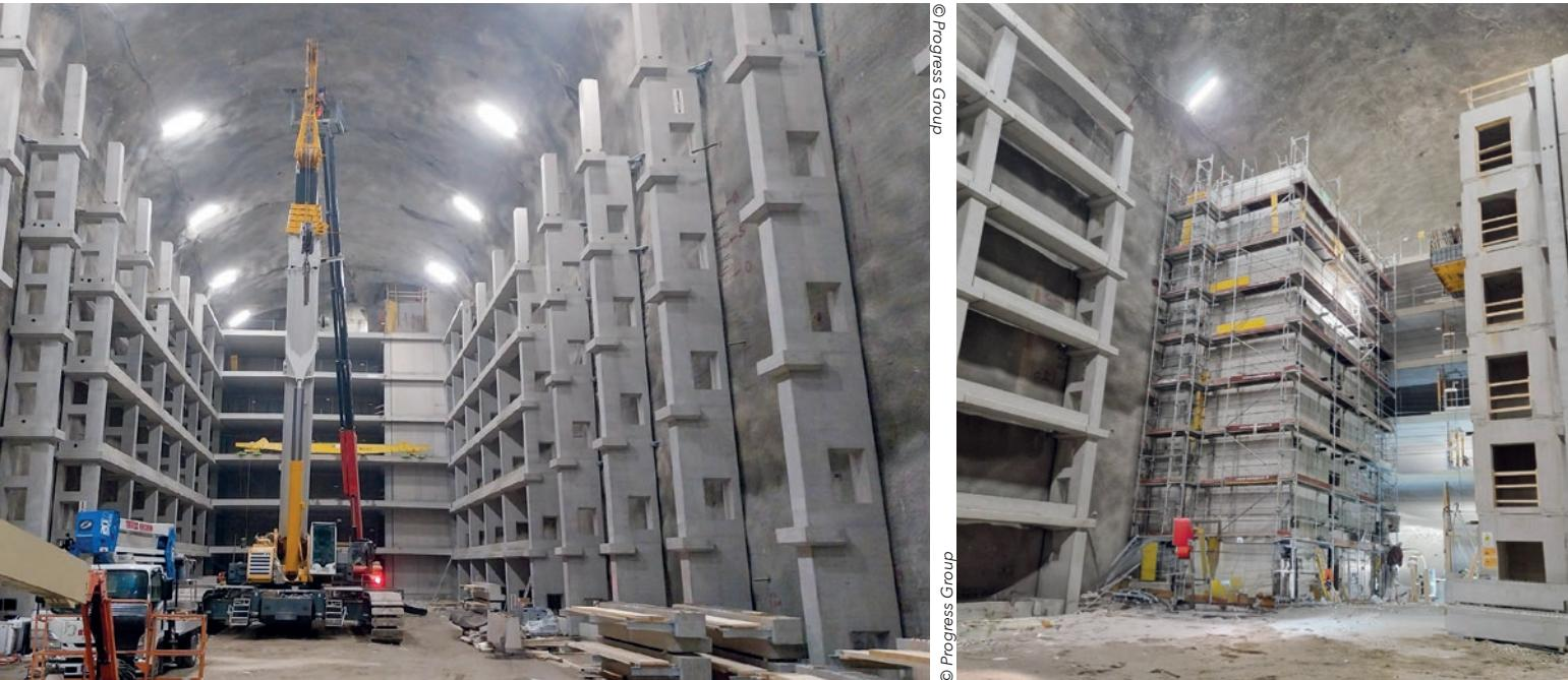
Sotto le strade di Merano attualmente viene realizzato un progetto infrastrutturale di grande impatto: un parcheggio sotterraneo disposto su sei piani nel tunnel del Kūchelberg. La caverna principale, lunga 170 metri, si raggiunge completamente tramite un tunnel, dispone di un accesso pedonale diretto per raggiungere il centro storico ed è un capolavoro tecnico.
