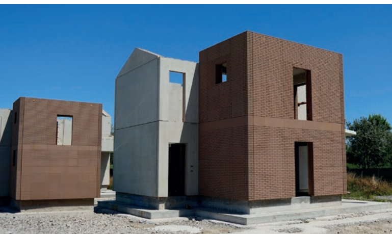
Maison de vacances à l'état de gros œuvre avec des éléments de façade imprimés en 3D en béton.
