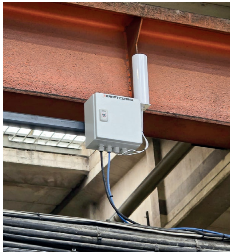
Un répéteur sans fil placé dans toute l'installation ou sur le site de l'usine pour assurer une force de signal suffisante sur une grande surface. Un câble à thermocouple pour mesurer la température interne du béton.
