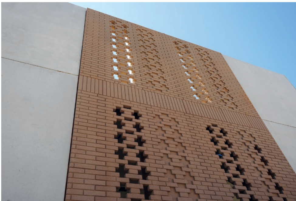
Elemento de fachada con aspecto de ladrillo impreso en 3D.
