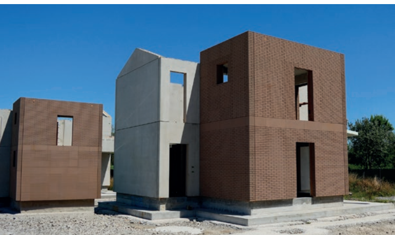
Casa vacacional en estado bruto con elementos de fachada impresos en 3D en hormigón.
