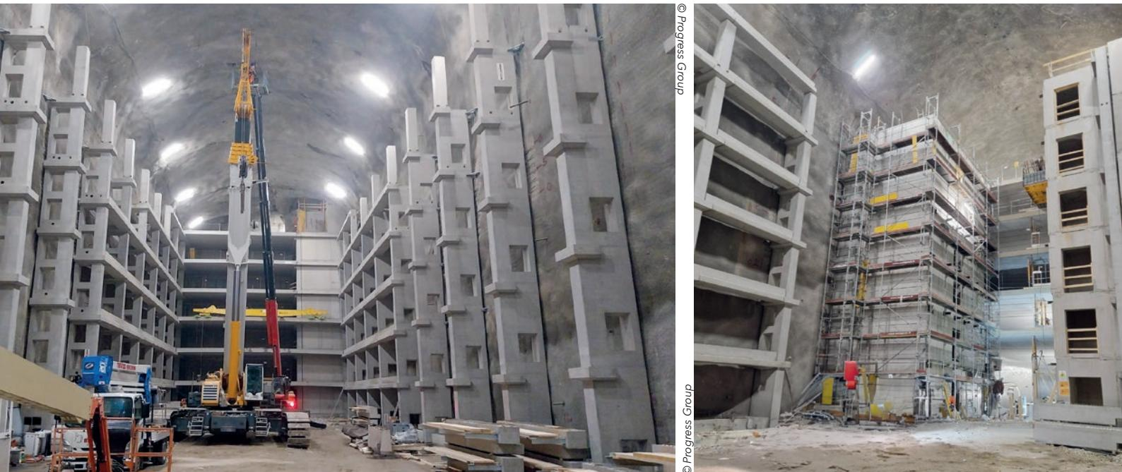
Bajo las calles de Merano se está realizando actualmente un proyecto de infraestructura realmente espectacular: un aparcamiento subterráneo de seis plantas en el túnel de Küchelberg. La caverna principal, de 170 m de longitud, totalmente accesible a través de un túnel y con acceso peatonal directo al centro urbano, es una obra maestra de la ingeniería.
