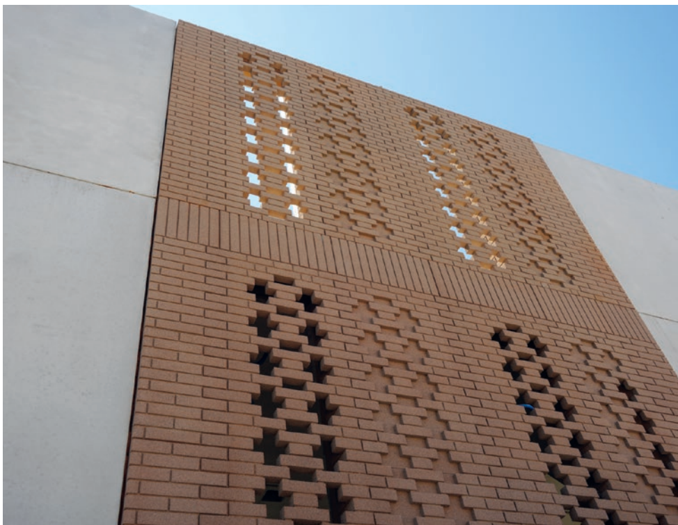
Fassadenelement mit 3D-gedruckter Backsteinoptik
