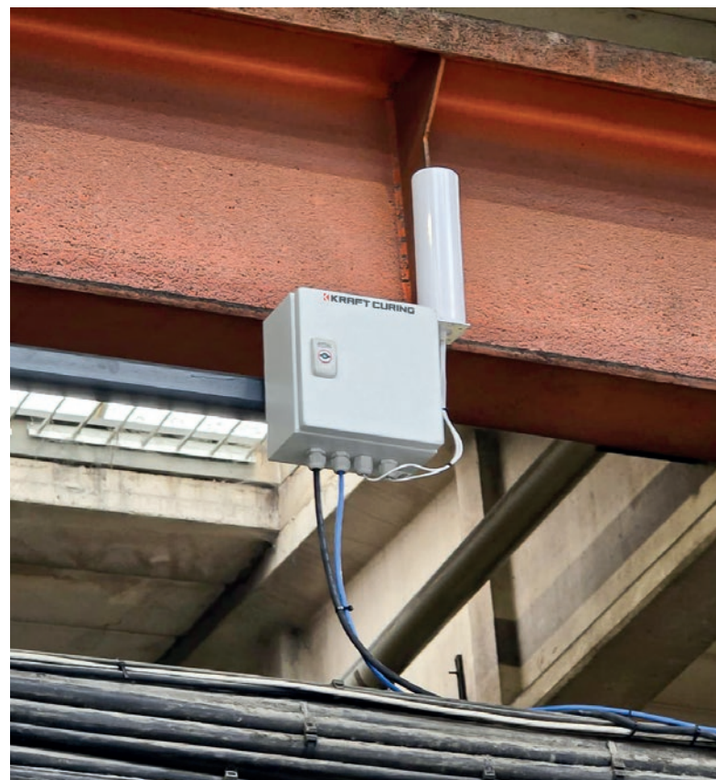
Ein drahtloser Repeater, der in der gesamten Anlage oder auf dem Werksgelände platziert wird, um eine ausreichende Signalstärke auf einer großen Fläche sicherzustellen. Thermoelementkabel zur Messung der Innentemperatur des Betons
